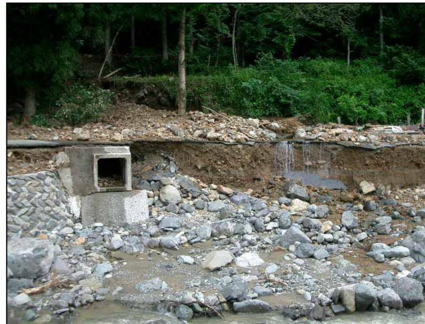
42. 池田町千代谷 部子川の氾濫により洗掘された護岸と小規模な土石流(左岸)
