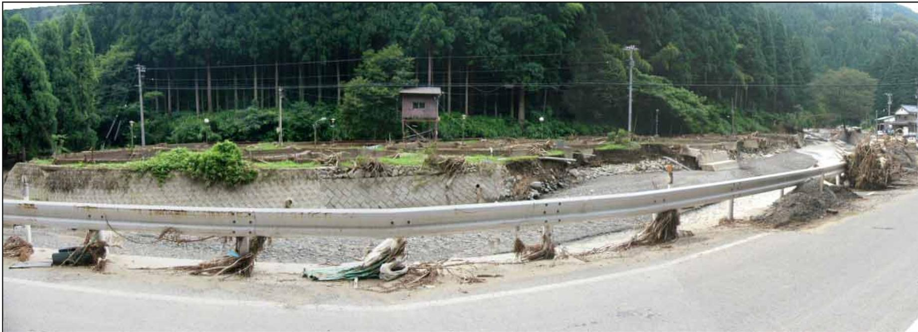
32. 池田町松ヶ谷 部子川の氾濫により破壊された護岸と養魚場
