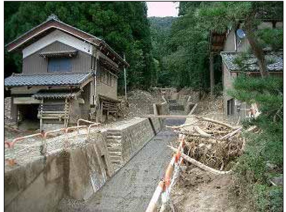
44. 池田町野尻 大規模な土石流の現場. 7/25には、土砂の撤去が手つかずの状態であったが、1週間後の7/31には河道部分の土砂が撤去されていた. 写真を比較すると、土砂の量が推定できる.
