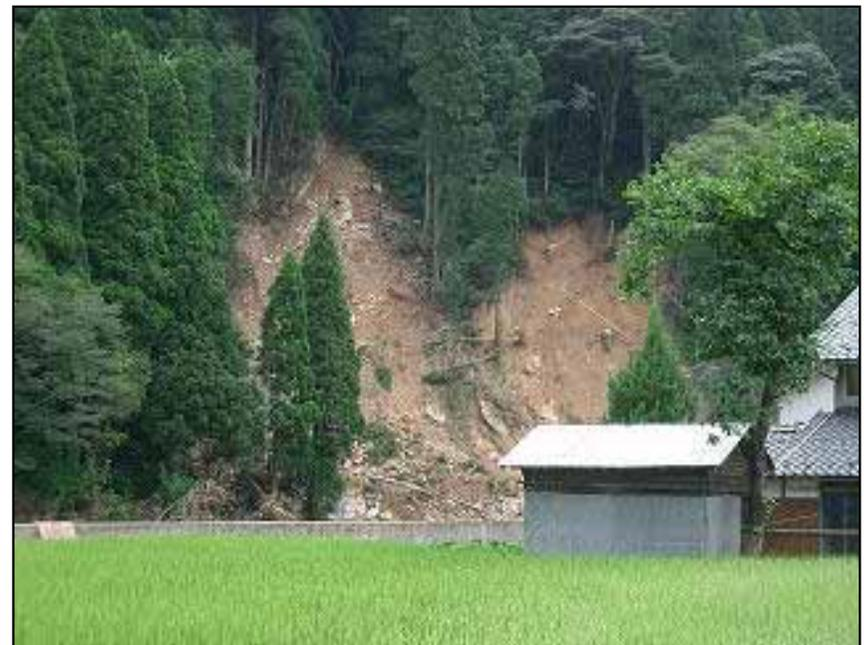
26. 池田町持越 足羽川左岸の崩壊地(土砂が町道を埋積した)
