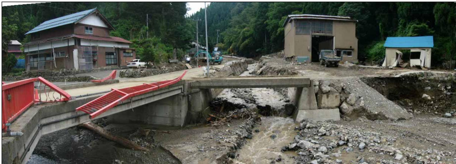
43. 池田町千代谷 金見谷川と部子川の合流点. 金見谷川よりでた泥流や土砂により河道の埋設及び家屋・倉庫・ガードレールなどが破壊された. 重機による土砂の撤去が進んでいる.
