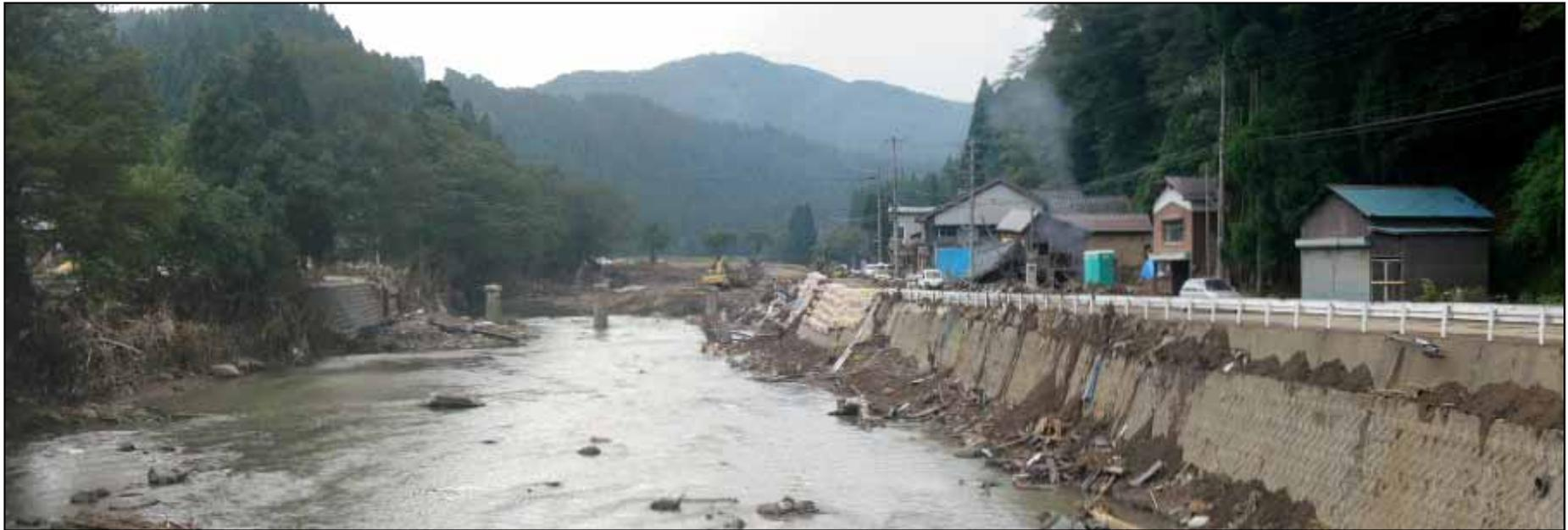
12. 美山町河原 国道の橋の上から上流を撮影(古い橋は落橋しており, 右側の民家が破壊されている. 護岸からガードレールにかけて流木やゴミが絡まっていた.)
