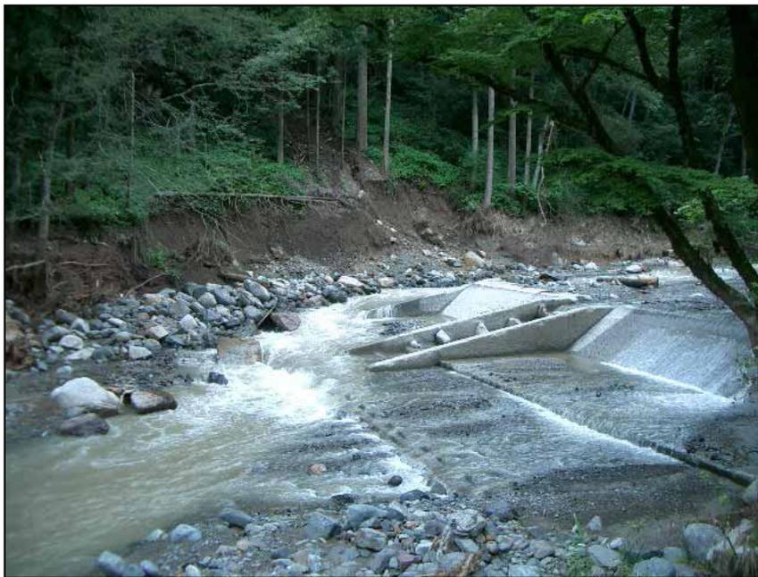
33. 池田町松ヶ谷～小畑 部子川河床の魚道が破壊されている
