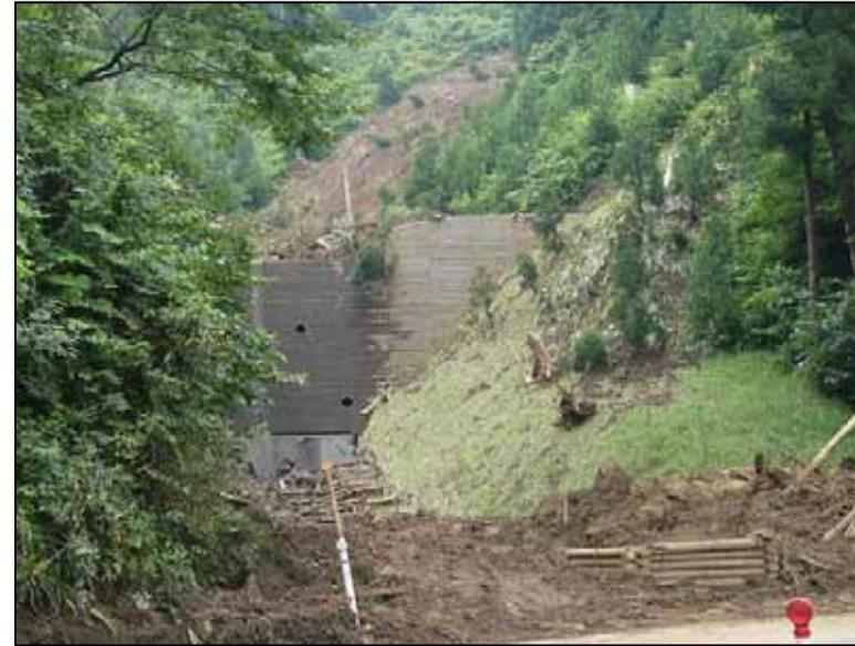
砂防堰堤で土石流の大部分が止まっている
