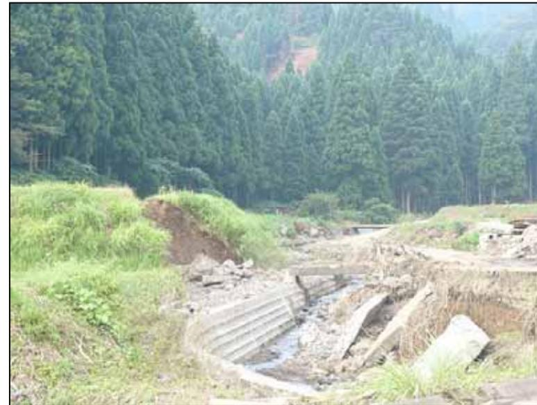
清水谷トンネルの池田町側 山腹に崩壊地があり、手前の河川では大水のために洗掘され護岸が破壊されている
