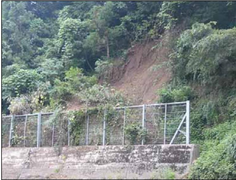
道路のり面の崩壊(対策工で止まっている)
