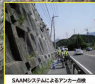
SAAMシステムによるアンカ一点検査
