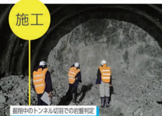
掘削中のトンネル切羽での岩盤判定
