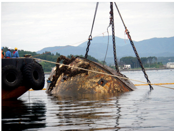
TANK-3の除去作業 (2012年8月15日)
