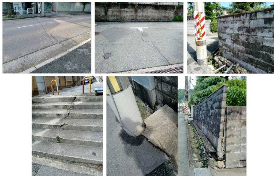
図2. 干渉 SAR 解析で大きな変位が観測された地域(図1の白矢印)の現地の様子の例
