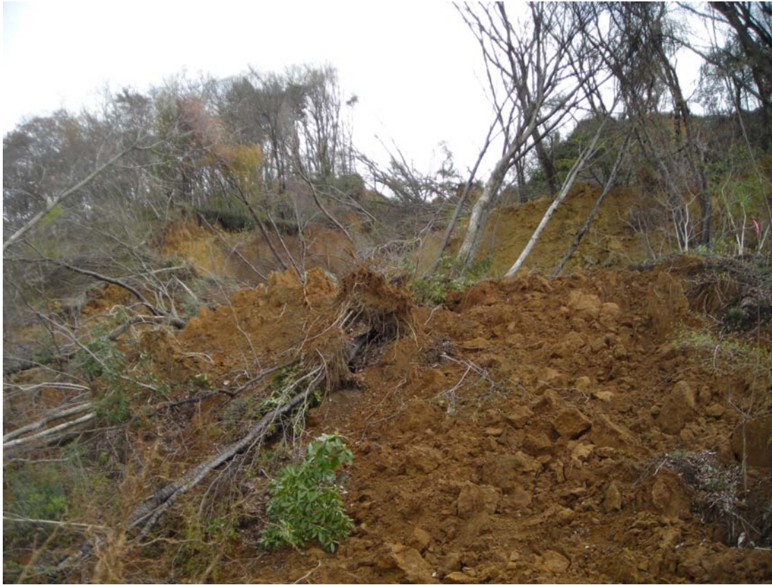
図 3. 上釜戸の大規模斜面崩壊
