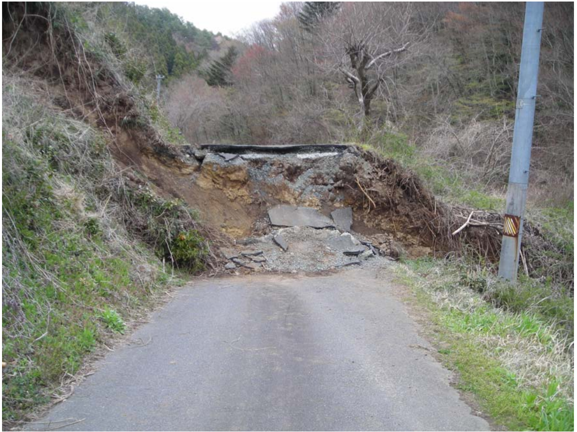
図2. 塩ノ平の地表地震断層.
