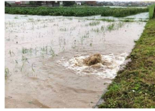
図-2 令和2年 筑後川のパイピング
