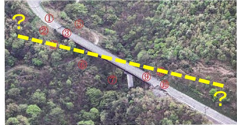
写真-1 俵山大橋全景斜め写真 3) (2016年4月)
