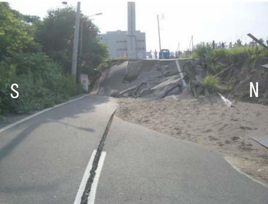
柏崎市橋場町クリーンセンター東. 地すべりにより南側に道路が崩落している. クリーンセンターの煙突は屈折している.
