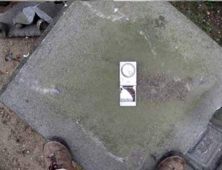
柏崎市諏訪町．石灯籠の台座に残った屈折する擦跡．上盤の移動方向が南東から南西を経て北西へと変化したことが判る．この擦跡を刻んだ灯籠の中段が北西側に転落する一方で，灯籠の上段は南東側に転落し，また隣接する地蔵や石柱も南東に転倒する．すなわち，北西-南東に卓越した振動が考えられる．
