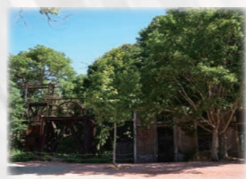
旧幾春別炭鉱錦立坑槽 (大正9年建設:三笠)
