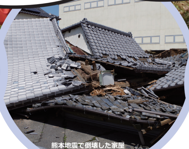
熊本地震で倒壊した家屋
