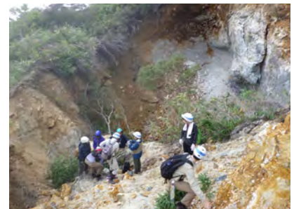
Bコース：Stop 4北側の新たな崩落・陥没部 (井村 匠撮影)
