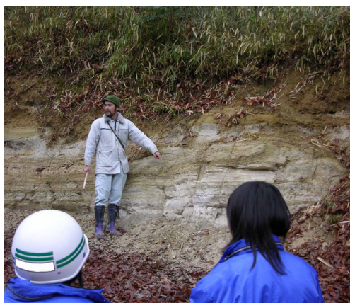
図5 園内にある露頭。中学校の実習で案内しているようす。
