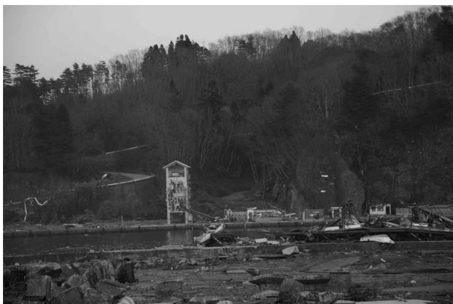
第2図 宮古市田老の津波表示板の遠望。10mの昭和三陸大津波、15mの明治三陸大津波の表示が見えるが、「明治」より高い位置に今回のゴミが見える。左の道路では、道路が左から右へ登るカーブで約21mの最大遡上高がわかる。
