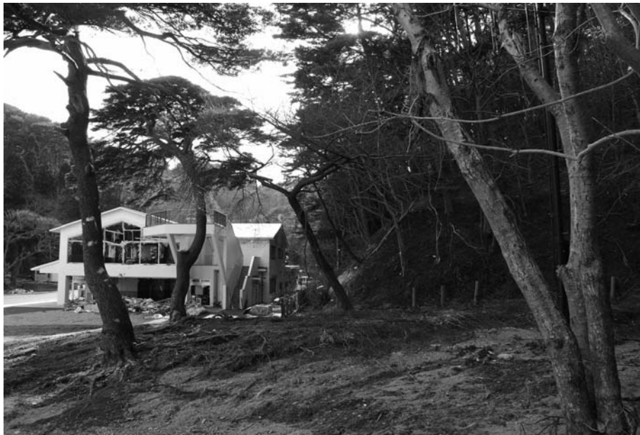
第1図 宮古市浄土ヶ浜の引波痕。破壊されたレストハウスの右側の山の斜面に明瞭に浸水深を示す枯れ葉の除去された跡が見える。
