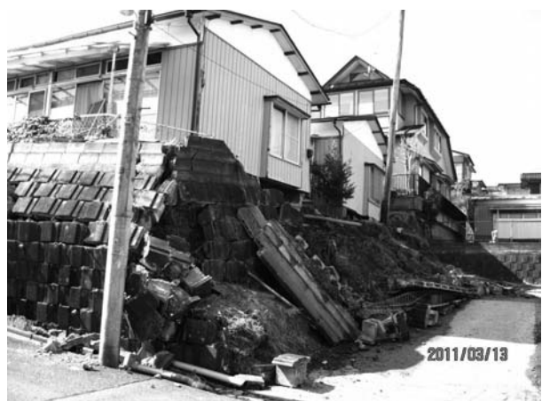
図7 仙台市の丘陵部における住宅地の斜面崩壊。
